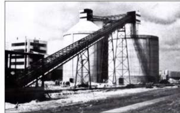
Die Vereinigten Aluminium Werke (VAW) im Bau, Anfang 70iger Jahre
